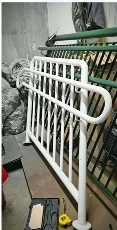
Foto 02: Montagem Parcial gradil com corrimão duplo (Presidência)
