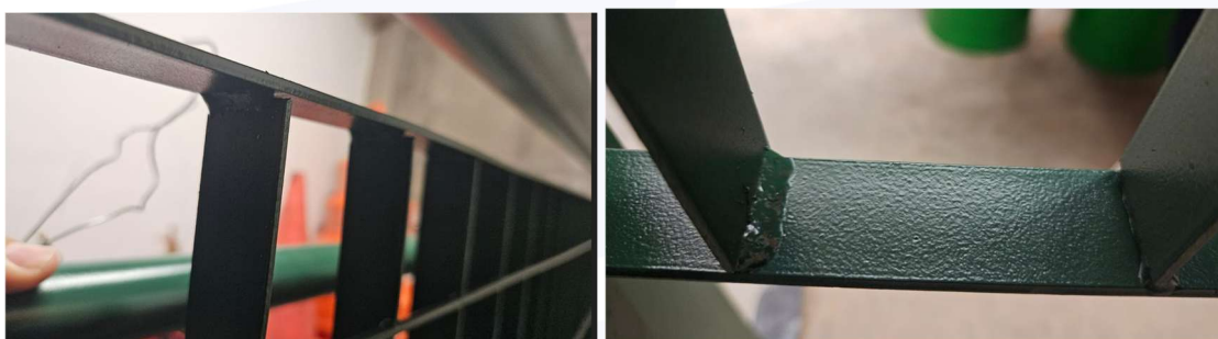
Foto 18 E 19 DETALHE FIXAÇÃO HASTES CHATAS DO GRADIL MODULAR ( ATENTAR CONTINUIDADE DE PONTOS DE SOLDA SUPERIOR E INFERIOR DE 1 LADO SÓ – CONTINUIDADE E NÃO DIXAR FRESTAS QUE PODEM SE RISCO PARA OS USUÁRIOS DEFICIENTES VISUAIS )
