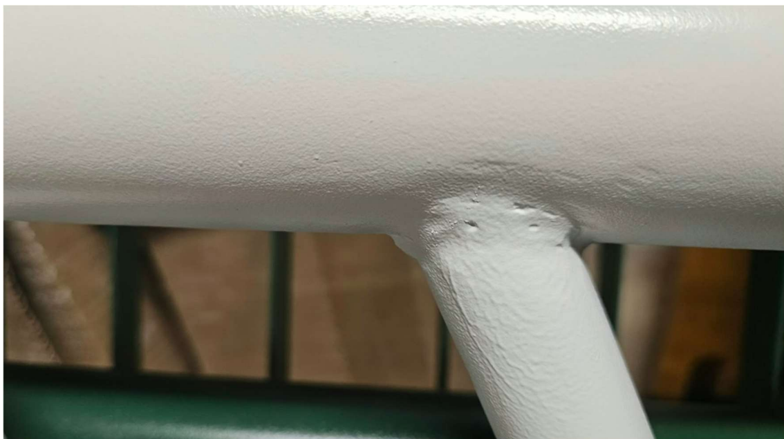
Foto 07 – Detalhe do acabamento da solda entre hastes verticais e barra horizontal.( ATENTAR A REGULARIDADE PARA NÃO DEIXAR FUROS NO ARREMATE )
