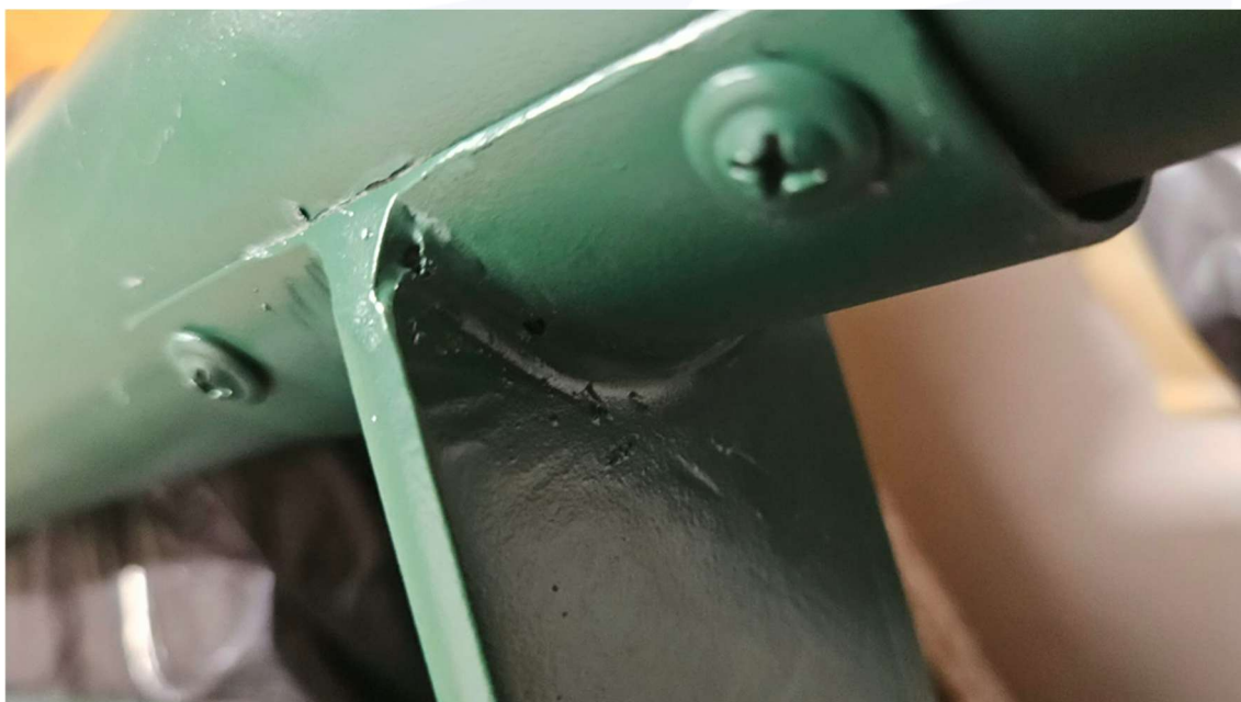
Foto 04 – Detalhe do acabamento da solda entre montante e suporte de fixação da travessa(tubo horizontal)
