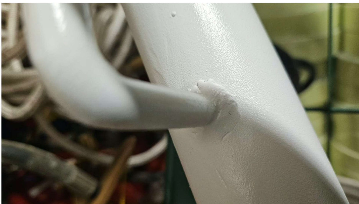
Foto 05 – Detalhe do acabamento da solda entre montante vertical e suporte de fixação do corrimão duplo.
