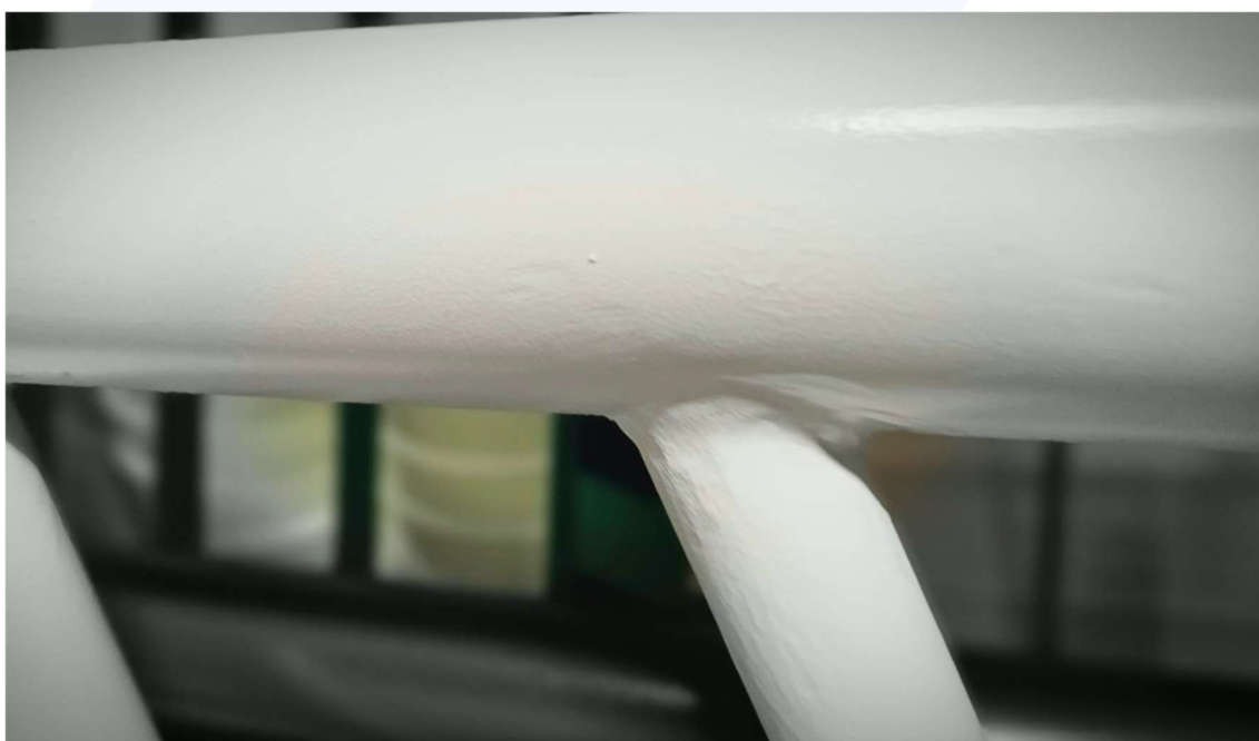
Foto 06 – Detalhe do acabamento da solda entre hastes verticais e barra horizontal.
