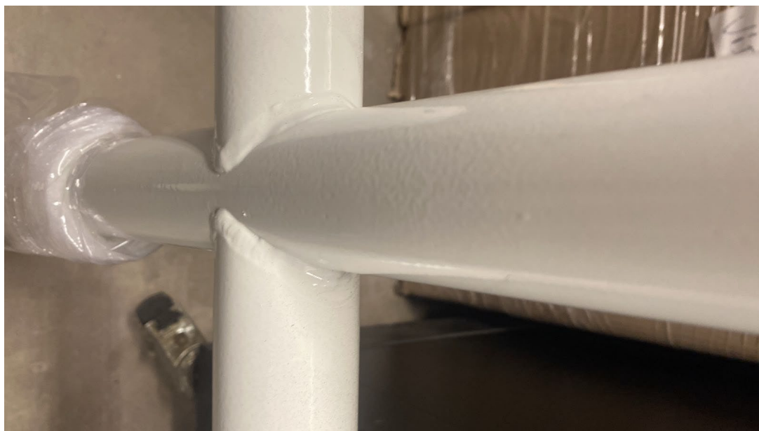
Foto 7 3 - Detalhe do acabamento da solda entre montante e travessa-
