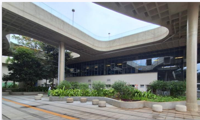
Figura 3 - Pilares e platibandas em concreto aparente
