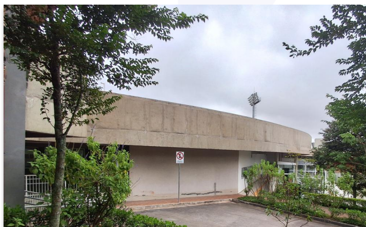
Figura 3 - Pilares e platibandas em concreto aparente
