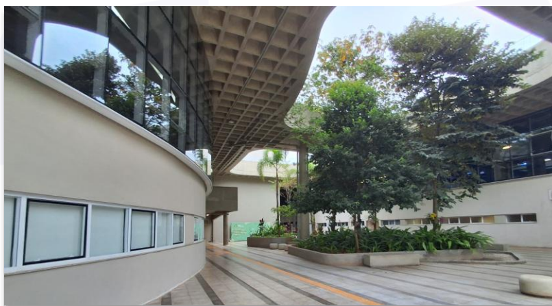
Figura 1 - Fachada em Textura dos blocos administrativos
